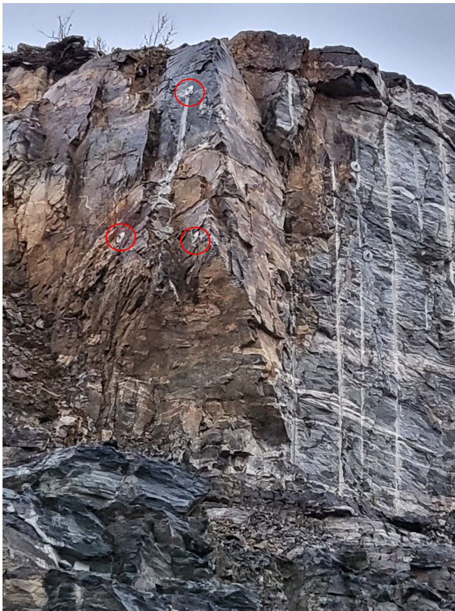
Foto 9: Blokk markert med rød ring i foto 8. Det kan se ut som blokken er sikret med 3 stk. bolter, markert med røde ringe. Boltemørtelen ser ut til å ha vært tyntflytende.
