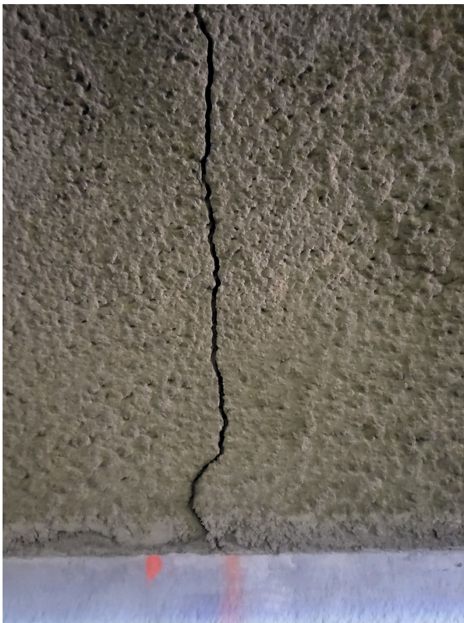
Foto 15: Eksempel på sprekk i brannsikring. Disse opptrer ca. hver 30. meter.
