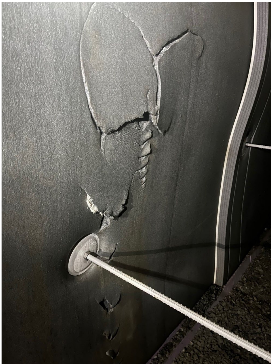
Foto 14: Skade på PE- skum (ikke i trafikkrommet) ved profil 80 høyre side.
