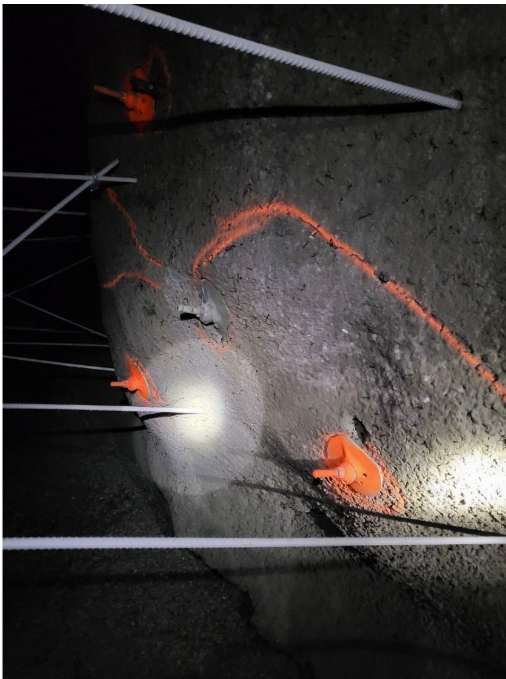
Foto 1: Oppsprukket sprøytebetong. Sprekk merket med oransje merkespray under hovedinspeksjonen.
