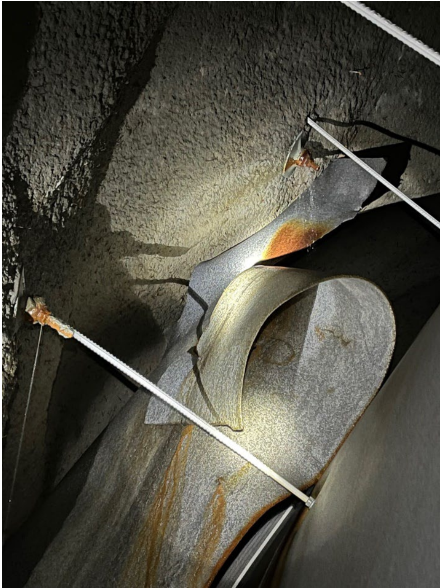
Foto 2: To bolter som er misfarget ved profil 1675, høyre side.
